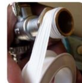
Brtvljenje teflonskom trakom
