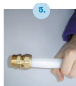
5. PRITEZANJE SPOJNICE POMOĆU ODGOVARAJUĆEG OTVORENOG KLUČA
