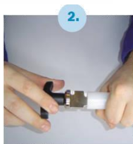
2. KALIBRIRANJE NA MJESTU REZANJA
