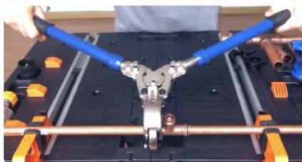
Spajanje bakrenih cijevi upresavanjem.
