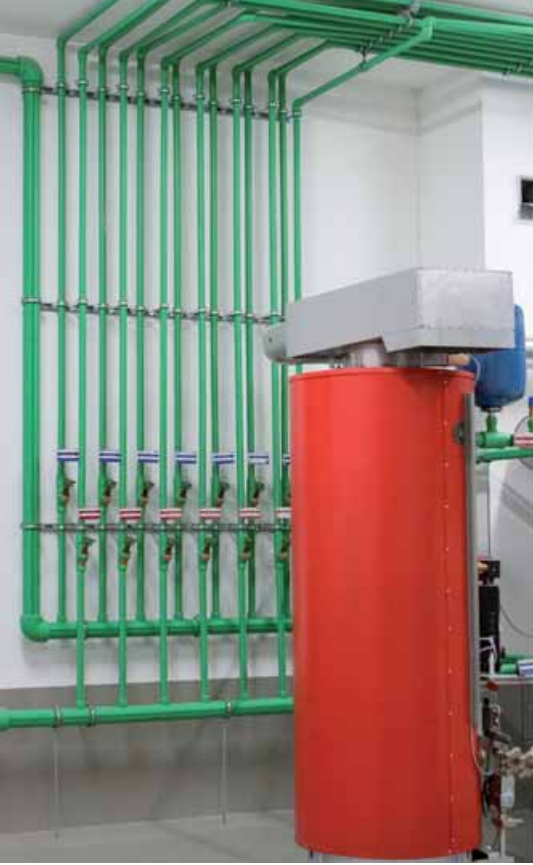
Mreža za razdiobu potrošne vode i vode za grijanje u stambenim zgradama
