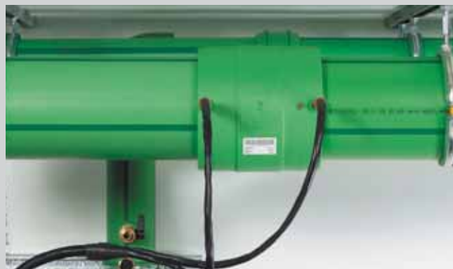
Aparat za zavarivanje podesiti na promjer spojnice. Pokrenuti postupak zavarivanja. Pridržavati se vremena hlađenja. Dovođeno!
