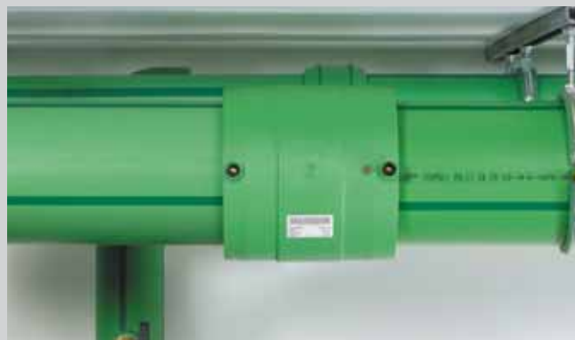
Umetanje drugog, također oljuštenog i očišćenog kraja cijevi u spojnicu.
