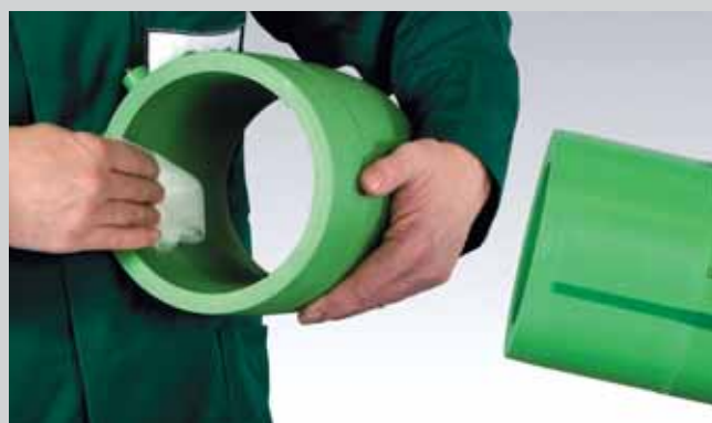
Očistiti unutarnju površinu E-spojnice
