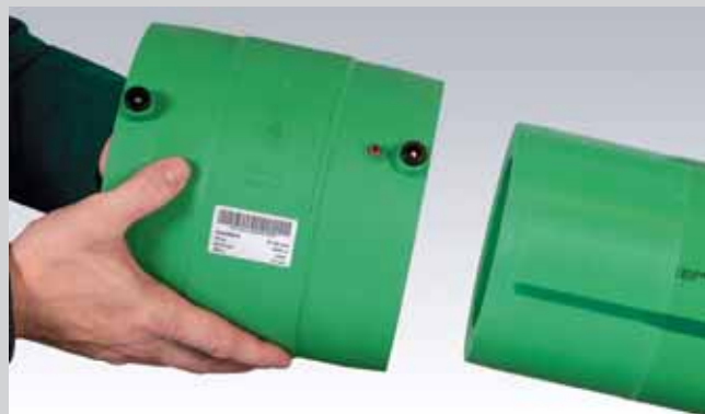
Nataknuti E-spojnicu na kraj cijevi
